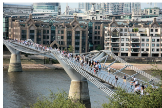
Millennium Bridge v Londýně (2000)
