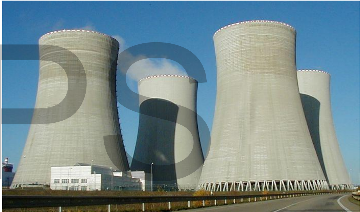
Chladicí věže u jaderné elektrárny Temelín – ČR ( http://www.celysvet.cz/geometrie/3/chlad3.jpg )
