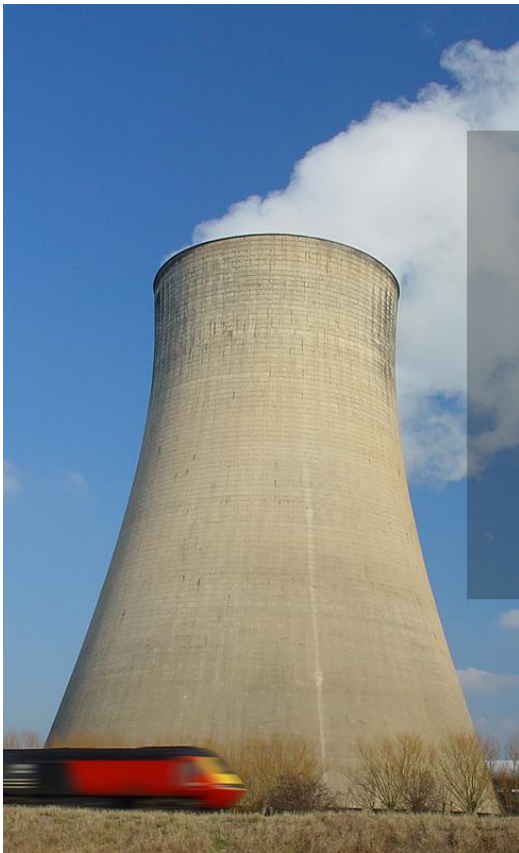
Chladicí věž tepelné elektrárny – Nottinghamshire, Velká Británie ( http://www.trekearth.com )
