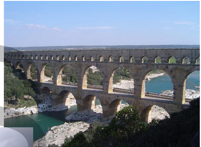
Akvadukt Pont du Gard - Francie ( http://www.trekearth.com )
