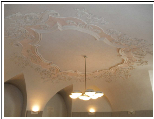
Strop v "Barboře"
