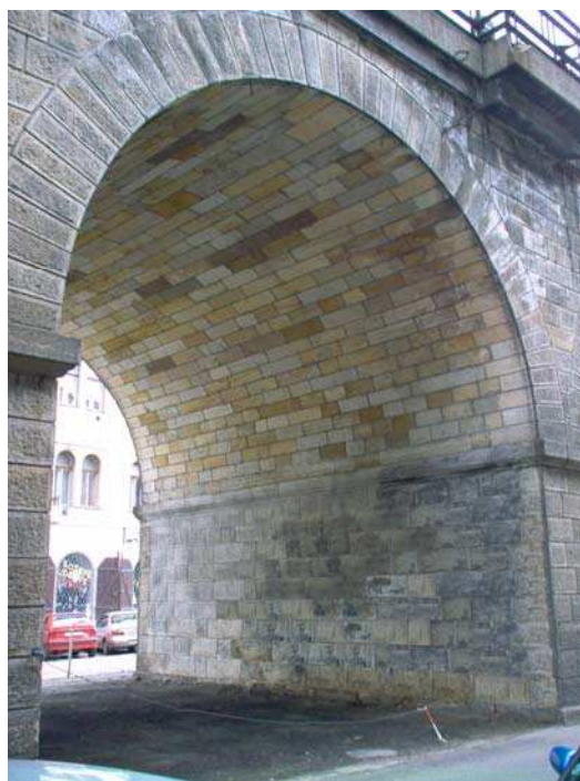
Obrázek 4.6: Valená klenba u Negrelliho viaduktu v Praze - ČR
