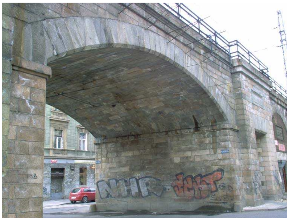
Příloha.2: Plocha šikmého průchodu na Negrelliho viaduktu v Praze - ČR
