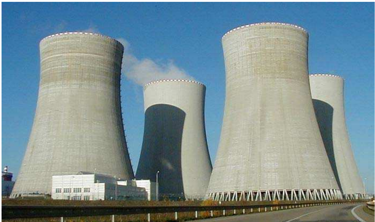
Příloha.1: Chladicí věže ve tvaru rotačního jednodílného hyperboloidu - jaderná elektrárna Temelín - ČR ( http://www.celysvet.cz/geometrie/3/chlad3.jpg )
