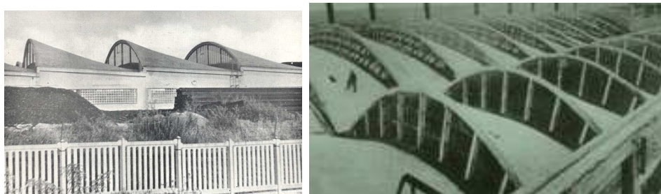
Obrázek 4.9: 65 parabolických konoidů nad plochou 100 x 130 m
