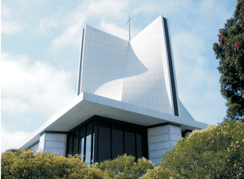
Obrázek 10: Hyperbolické paraboloidy u zastřešení – St. Marys Cathedral – San Francisco, USA
