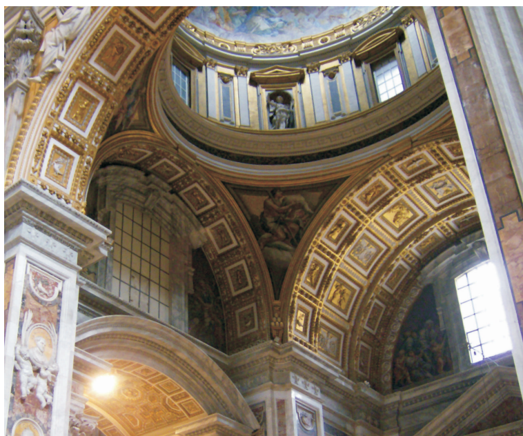
Obrázek 13: Použití části kulové plochy a pendentivů k zaklenutí – Bazilika sv. Petra – Řím, Itálie
